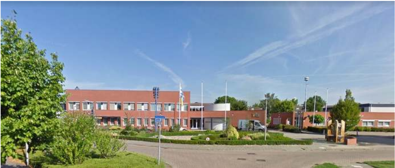
Het voormalige gemeentehuis van Piershil © Google Streetview
